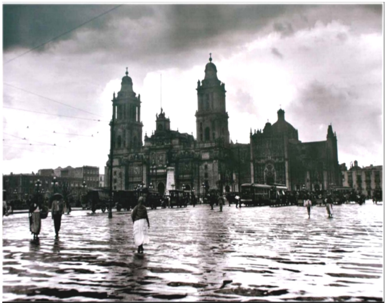
ZÓCALO DE LA CIUDAD DE MÉXICO, CUBIERTO DE AGUA Fotografía tomada de www.excelsior.com.mx
